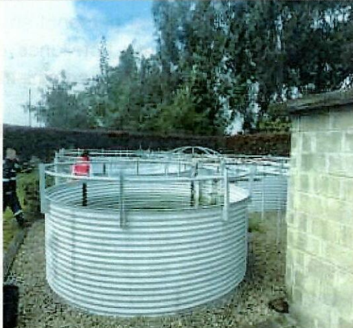
Sistema de captación de aguas lluvias del Parque Industrial Las Mercedes
