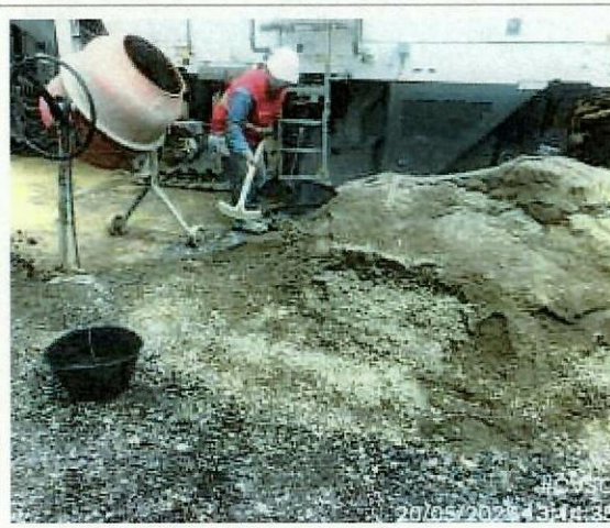
Mezcla de cemento en obra
